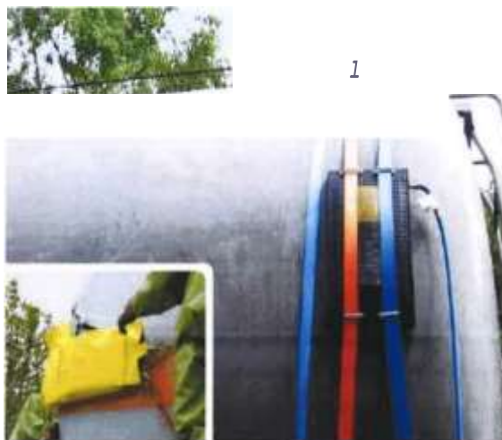
2.att. Pneimatiskā spilvena uzlikšana un savilkšana uz bojātās cisternas
