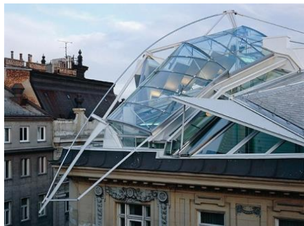
4. attēls. Coop Himmelb(l)au Jumta pārbūve. ( https://www.pinterest.com/1ww6b5ojw0g2l4y/parasite-arq/ ).
