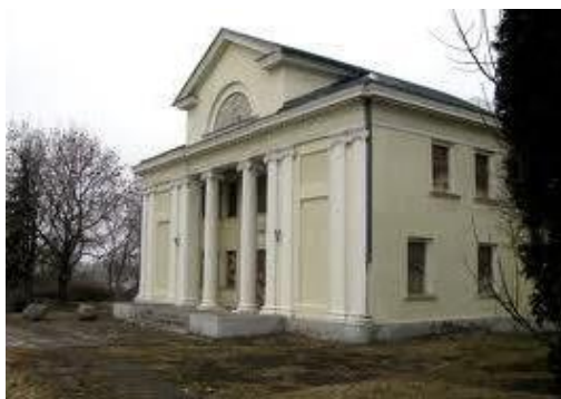
4. attēls. Kinoteātris “Uzvara”. Bauska. Kalna ielā 5. (1954). Arh. Z. Brods. ( http://2.bp.blogspot.com/-LiGV3mjaMLk/UWC- ).
